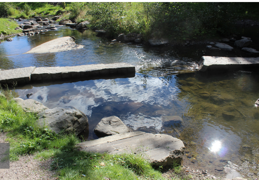
FIGUR 32 Exempel på hur block både kan användas som enkel passage, men även som dammvall.
