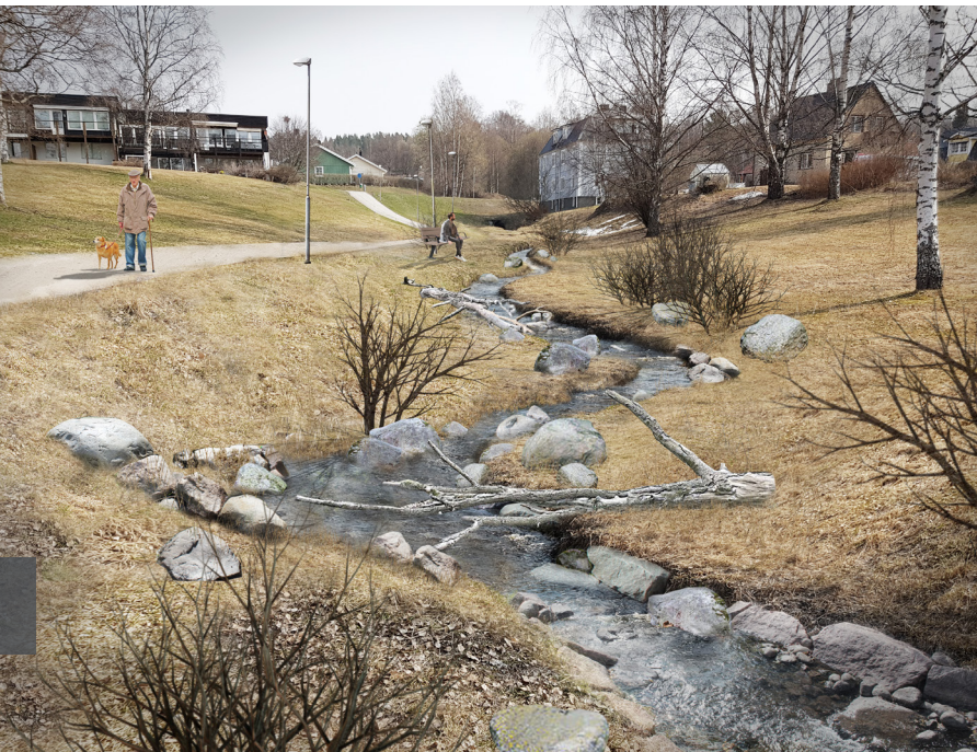
FIGUR 20 Gerestabäcken som den skulle kunna utformas. Block skapar variation i bäcken och en svag meandring skapar ett mer funktionellt vattendrag för olika arter.
