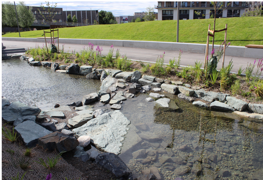
FIGUR 30 Ett annat exempel på utplacerade block eller berg i dagen som kan nyttjas för passage över bäck
